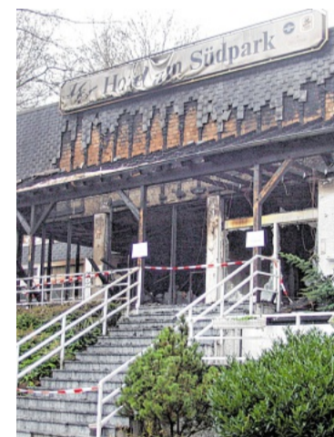
Die verwahrloste Hotelruine an der Höntroper Straße wurde Ende 2017 abgerissen.
