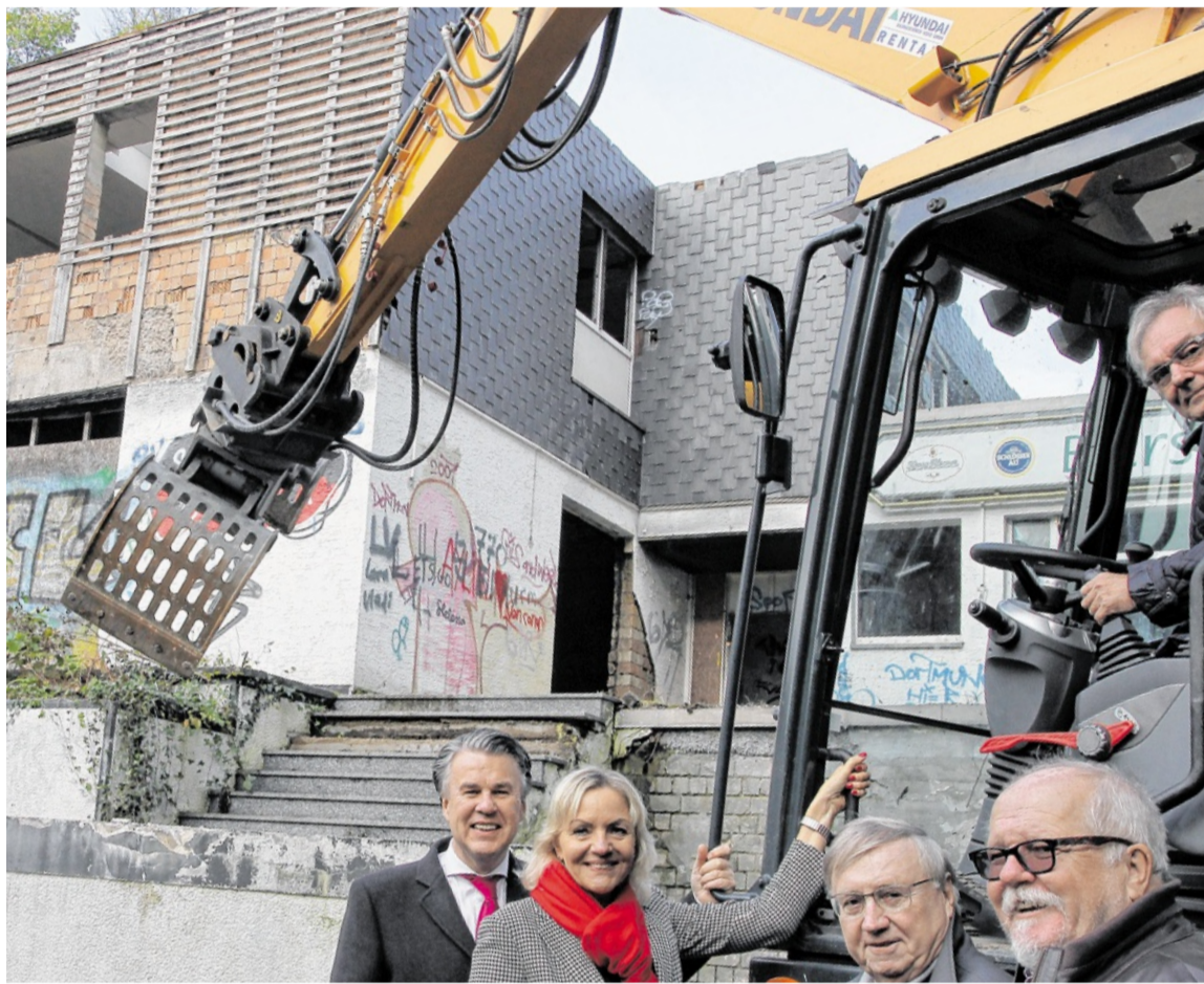
Den Startschuss per Bagger für den Abbruch der Brandruine „Hotel am Südpark“ gab Bezirksbürgermeister Manfred Molszich symbolisch. Hier sitzt er im Führerhaus. Von links: Karsten Koch und Beatrix Knipping (Markus-Bau), Ratsmitglied Dieter Fleskes und Karlheinz Kayhs, Leiter der Bezirksverwaltungsstelle Wattenscheid.
