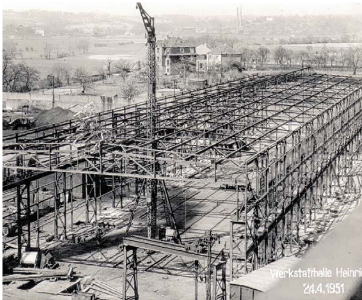
Schon in dieser frühen Bauphase waren die mächtigen Dimensionen der Heinrich-Halle zu erkennen. FOTO: SAMMLUNG RAINER BUSCH
