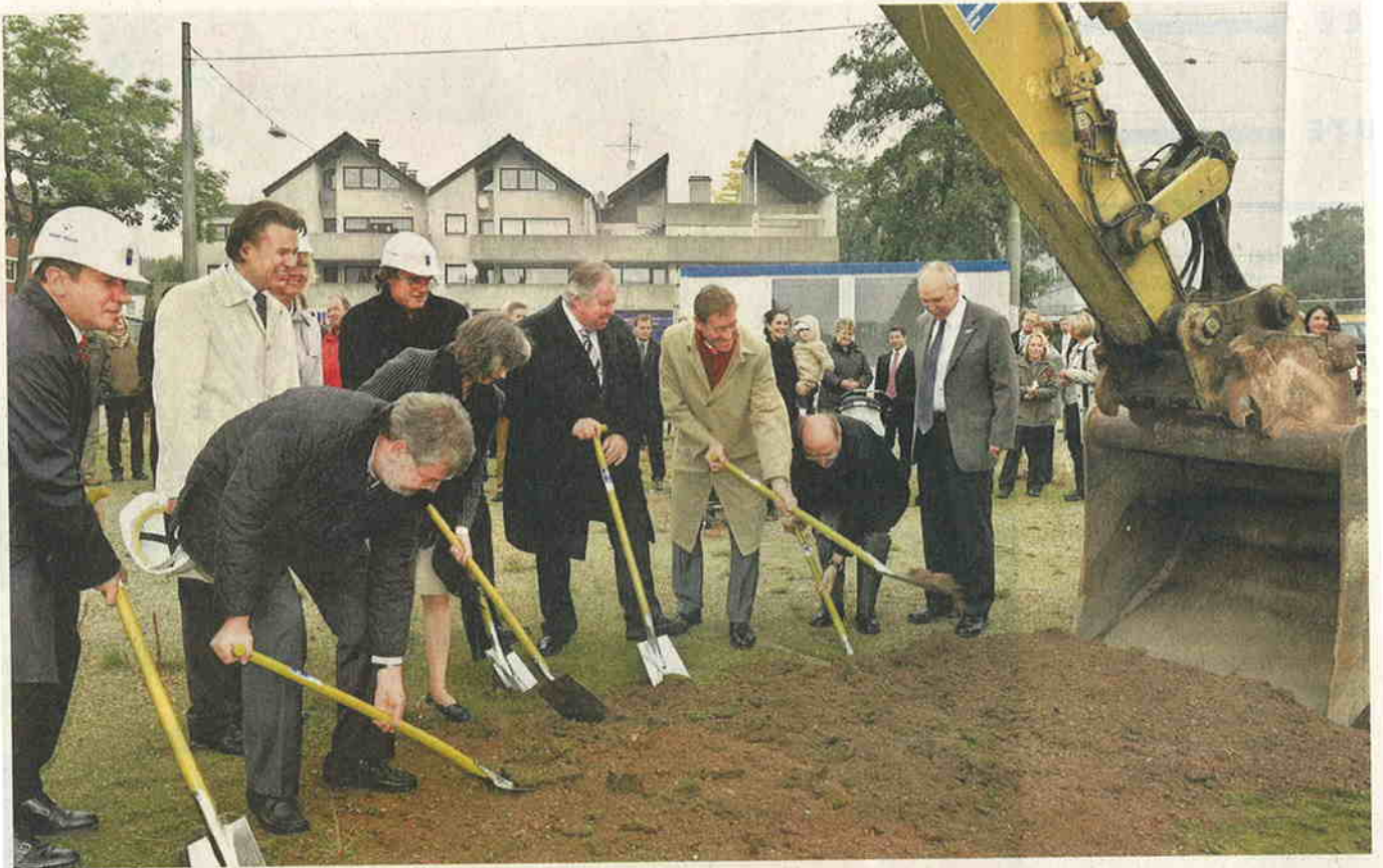
„Feiner Zwirn“ war zum offiziellen ersten Spatenstich angesagt. Doch ab heute wird Arbeitskleidung auf dem früheren BOGESTRA-Gelände an der Wittener Straße dominieren – bis es beim Richtfest wieder feierlicher wird. RN-Foto Aschwer
