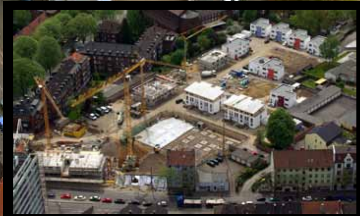
Q100: Die Bauphase
